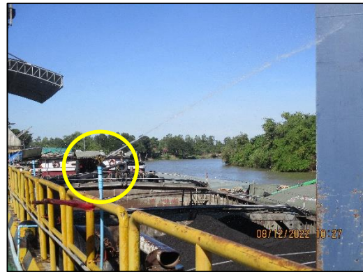
ภาพที่ 2.4 การติดตั้งสเปรย์น้ำบริเวณที่มีการลำเลียงถ่านหินขึ้นจากเรือ
