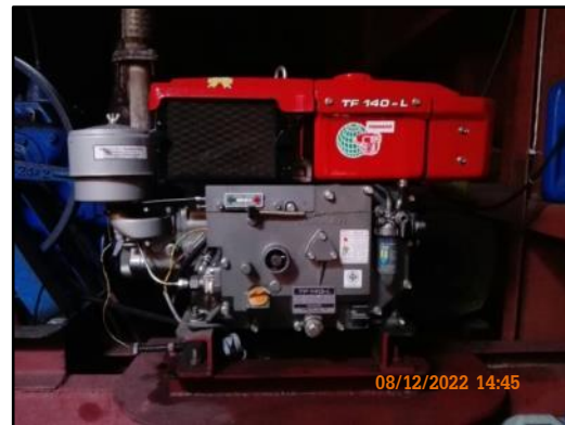
ภาพที่ 2.51 เครื่องปั่นไฟพร้อมสายไฟและ ปลั๊กไฟภายในเรือลำเลียงสินค้า
